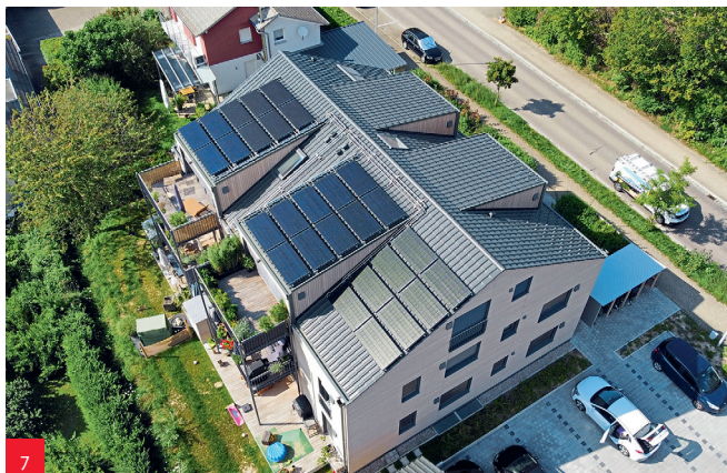
Beim Teiltrückbau und der Wiederaufstockung eines Mehrfamilienhauses in Heitersheim bei Freiburg durch die Steiger & Riesterer GmbH, Staufen, ging es in erster Linie darum, den KfW-40+-Standard sinnvoll umzusetzen.
