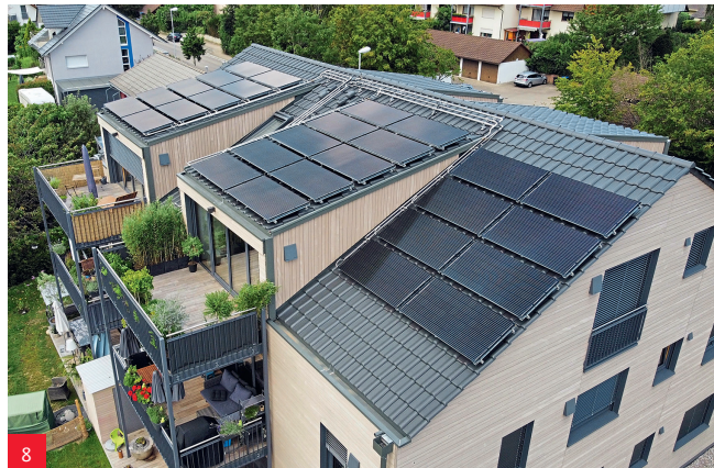
Seit Dezember 2020 versorgt die PVT-Wärmepumpenanlage sechs Wohnungen mit einer Gesamtfläche von 560 m 2 in Heitersheim bei Freiburg mit Strom und Wärme.
