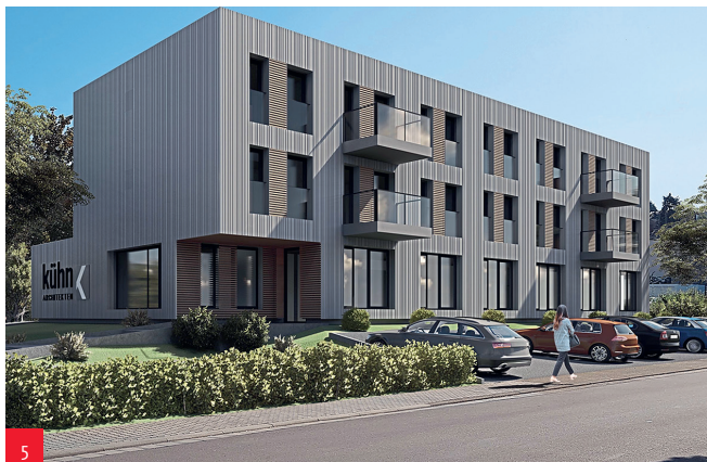
Mischgebäude im saarländischen Eppelborn: Vier Wohnungen und ein Büro auf einer Gesamtfläche von 900 m 2 werden über 75 PVT-Kollektoren und zwei 17-kW-Wärmepumpen mit Heizwärme und Warmwasser versorgt.
